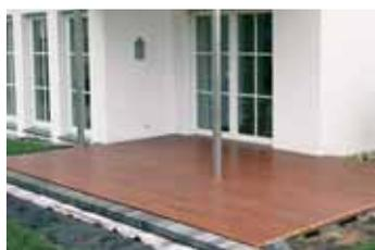
An den Aussenkanten der kompletten Terrasse sollten entweder Abschlussbretter, oder auch eine Einfassung mit Steinen den Abschluss bilden. Die Kopfenden der Bretter sollten eine Fasse bekommen und an den Schnittstellen versiegelt werden.
