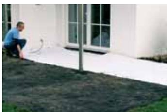
Der Untergrund sollte aus einem wasserdurchlässigen Bodenaufbau sein. Optimal wäre eine Sandschicht in einer Kiesschüttung und anschließend einem Wurzelvlies. So kann Staunässe vermieden werden.
