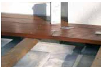
Wenn die Unterkonstruktion komplett ausgerichtet und befestigt worden ist, können die Bodenbretter verschraubt werden. Fangen Sie mit dem Verlegen an der Hauswand an. Achten Sie auf eine ausreichende Hinterlüftung der Terrassendielen und einen Abstand von min. 8 mm zur Hauswand.
