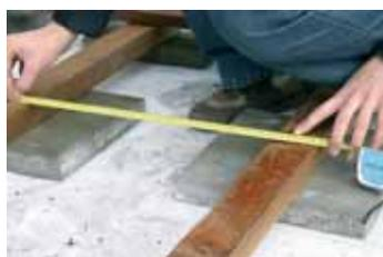
Ein ausreichend stabiles Fundament für die Terrasse können Sie mit Betonplatten erreichen. Ein leichtes Gefälle von 1-2% sorgt für einen ausreichenden Wasserablauf. Der Abstand der Betonplatten sollte in der Breite max. 50 cm und im Abstand der Reihen max. 70 cm betragen.
