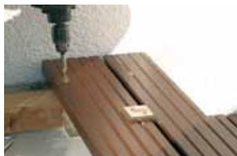
Die Bretter sollten mit einem Abstand von 5-8 mm verlegt werden. Am besten verwenden Sie gleichstarke Abstandsklötze. Bitte zwischen Unterkonstruktion und Bodenbretter eine Gummischnur von ca. 4mm einlegen.
