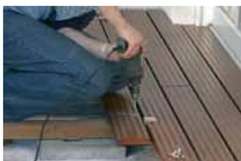
Jedes Brett sollte in der Breite mit 2 Schrauben auf der Unterkonstruktion verschraubt werden. Die Schraublänge sollte die ca. 2,5-fache Länge der Stärke der Bretter betragen. Die 2 Verschraubungen pro Brett in der Breite sollten möglichst weit auseinander liegen.
