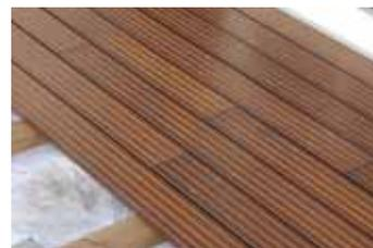
Bei unseren Systemlängen ist eine Verlegung im wilden Verband möglich. Jedoch müssen die kürzesten Stücke mindestens auf 2 Unterlagern aufliegen. Mit den Systemlängen können Sie den Verschnitt und den Verzug des Holzes minimieren.
