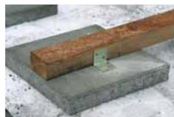
Die Unterkonstruktion ist so stark zu dimensionieren, dass diese dem Verzug durch Quellen und Schwinden standhält. Eine ausreichende Befestigung auf dem Untergrund ist immer erforderlich. Der Abstand der Hölzer sollte nicht mehr als 40-50 cm betragen. (je nach Brettstärke)
