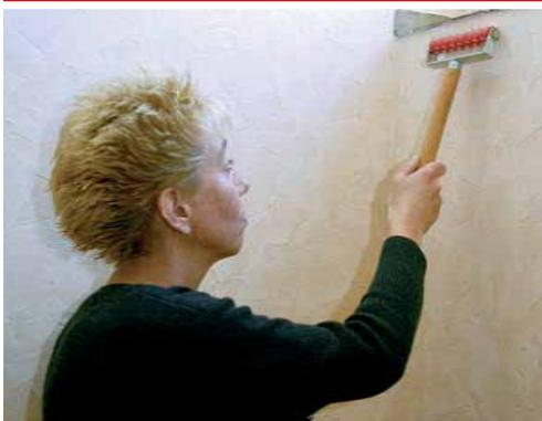
Mit der Stachelwalze wird die Tapete perforiert, damit der Dampf des Tapetenablösegerätes (S. 72) besser auf die Leimschicht durchdringen kann.
