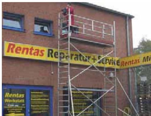
Das Aluminium-Rollgerüst ist einfach, schnell und ohne Werkzeug aufzubauen. Höhen- und Niveaueausgleich erfolgt über Lenkrollen. Arbeitshöhen sind ab 3 m in 1- m-Abstufungen bis max. 13,2 m möglich. Bitte beachten: Die Standhöhe ist 2 m niedriger als die Arbeitshöhe. Die Gerüsthöhe ist ca. 0,75 m niedriger als die Arbeitshöhe.
