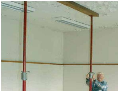
Die Baustützen (Schalungsstützen) sind mit einem Flachkopf ausgestattet und zum Abstützen von Decken bei Wanddurchbrüchen notwendig.
