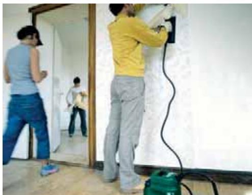
Mit dem Tapetenablösegerät werden Tapeten mit Wasserdampf umweltfreundlich abgelöst. Um die Effizienz zu erhöhen, sollte die Tapete vorher mit der Stachelwalze (S. 71) perforiert werden.
