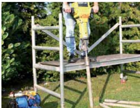
Mit dem schweren Aufbruchhammer und einem Adapter für Brunnenrohre wird das Rohrgestänge in den Erdboden eingetrieben. Das Gerät ist nicht geeignet für steinige Untergründe.
