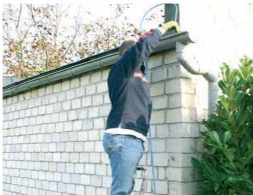
Der Rohrreinigungsschlauch wird mit einem Hochdruckreiner betrieben. Der Hochdruckschlauch schiebt sich durch den Rückstrahl selbst ins Rohr. Dabei bohrt sich ein Wasserstrahl nach vorn durch die Verstopfung, während drei nach hinten gerichtete Wasserstrahlen den Vortrieb verursachen und zugleich die Rohrwandungen sauber spülen.
