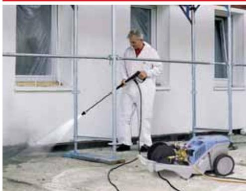
Der Arbeitsdruck von bis zu 140 bar bei einem Wasserdurchlauf von 660 Litern in der Stunde gewährleistet ein bestmögliches Reinigungsergebnis. Mit der rotierenden Schmutzfräse kann der Reinigungseffekt noch deutlich erhöht werden. Mit dem Sonderzubehör „Terrassenreiniger“ kann spritzwasserfrei gearbeitet werden.
