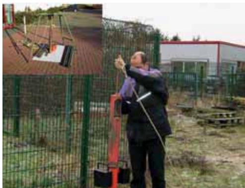
In sandigen oder kiesigen Untergründen rutscht beim normalen Bohren der Sand/Kies immer wieder in das Bohrloch nach. Hier wird mit dem Plunsker das Wasser/Sand-Gemisch herausgehoben, während gleichzeitig das Brunnenrohr in das Bohrloch geschoben wird. Bis zur losen Sand-Kiesschicht wird mit einem Handbohrer vorgebohrt. Die Bohrtiefe richtet sich nach dem geologischen Untergrund.
