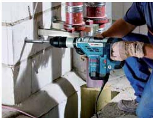
Mit dem mittelschweren Bohrhammer kann man bis 40 mm bohren, zusätzlich besteht die Möglichkeit mit einer 125 mm Krone zu bohren.
