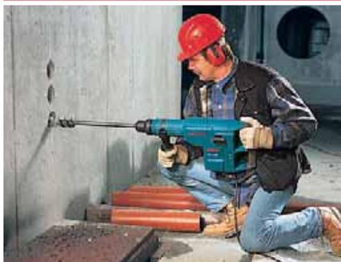
Mit dem schweren Bohrhammer kann man bis 52 mm bohren, zusätzlich besteht die Möglichkeit mit einer 150 mm Krone zu bohren.
