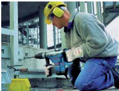
Mit dem mittelschweren Bohrhammer kann man bis 30 mm bohren, zusätzlich besteht die Möglichkeit mit einer 90 mm Krone zu bohren.
