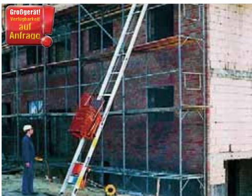
Durch geringes Eigengewicht und leichte Montage ist der Elektrolift schnell einsatzbereit. Der Lift besteht aus 6 Elementen von je 2 m und einem Element von 1 m. Durch ein Kniestück kann der Lift an der Dachkante der Dachneigung angepasst werden, so dass der Förderkorb bis zum First fahren kann.
