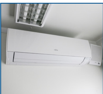
Klimaanlagen mit Split-Geräten
