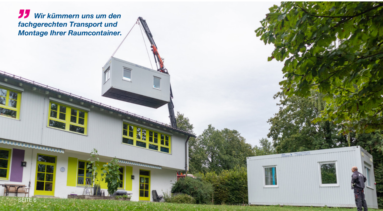
Positionierung und Kopplung der Container
