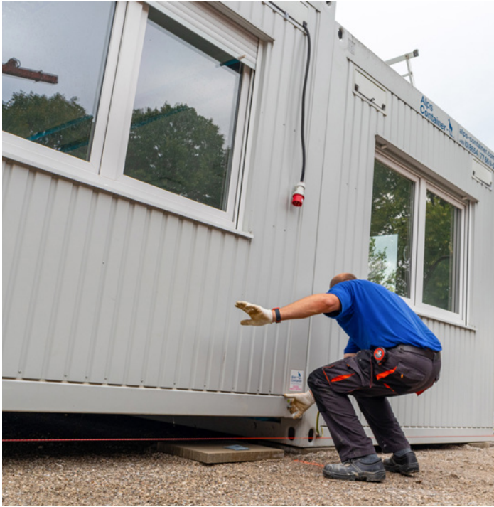
Positionierung und Kopplung der Container
