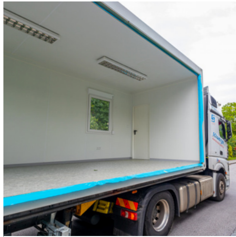
Anlieferung von Raummodulen
