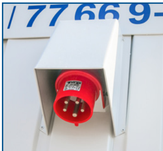
Aufgesetzte Außensteckdosen
