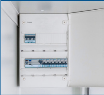
Sicherungskasten mit FI-Schutzschalter und Einzelabsicherungen
