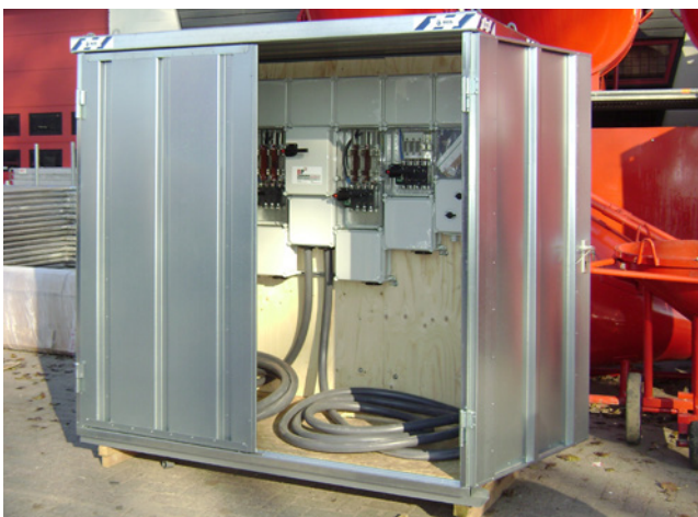
Einhausung für Stromverteilerkasten
