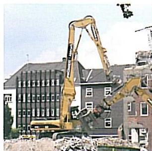
Erschütterungsmessungen beim Gebäuderückbau
