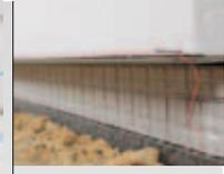
**03** Sofort nachdem an einer Wandseite die Quix-Elemente verklebt sind, werden sie entlang einer Schnur flucht-recht ausgerichtet.
