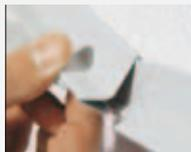
**06** Bei Kratzputz als Oberputz ist zur Stabilisierung der Kante das Quix Aufklempprofil zu verwenden. Dieses wird stoßversetzt auf die Putzleiste geklippt. (Nur bei Hausecke Eckig.)
