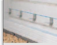
**01** Zu Beginn wird ein horizontaler Schnurschlag 16 cm über der gewünschten Sockelhöhe angebracht. An diesem ausgerichtet werden die Quix Montagewinkel alle 60 cm mit Schmelzkleber am Untergrund befestigt.
