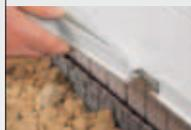
**05** Putzprofile auf die Abschlussplatte aufstecken, mit den Stifen verbinden und ausrichten.
