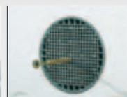
02 Vor dem Überputzen werden die betreffenden Stellen mit Schrauben oder Stiften markiert, um deren Wiederauffinden zu garantieren. Die Befestigung des jeweiligen Bauteils erfolgt nach Fertigstellung des Putzes.
