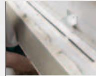
**02** Jetzt wird MARMORIT Klebe-mörtel im Rand-Wulst-Verfahren auf die Quix-Elemente aufgetragen und diese anschließend mit dem rückseitigen Montageschlitz auf die Quix Montage-winkel aufgeschoben und angedrückt.
