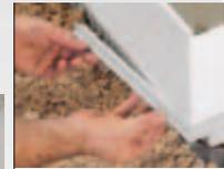
**04** Die Eckausbildung ist denkbar einfach. Die Quix-Elemente werden wie in der Fläche auch bei Innen- und Außen-ecken stumpf gestoßen. Die auf Gehung geschnittenen Eckstücke werden an den Innen- und Aus-senecken aufgesteckt.
