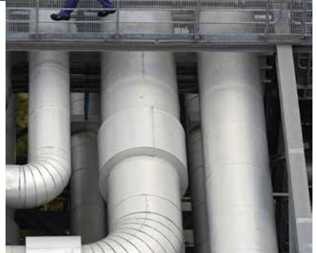
Chemische Medienverteilungsanlage
